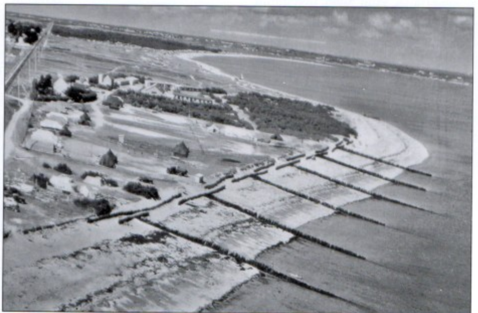
En 1958, vue du domaine de la Cité des Jeunes Ardennais avec l'implantation des fascines pour protéger le site de l'érosion marine. Col. J.-P. Denneulin.
