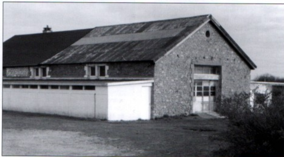
Les deux ensembles blancs bordent le grand réfectoire, correspondent à l'intendance à gauche, à la boutique, à la lingerie et à la plonge à droite. Ces constructions modernes ont été réalisées dans les débuts de la Cité. Le bâtiment en pierre était une partie de la ferme à goémons. Ph. J.-P. Perisson.
