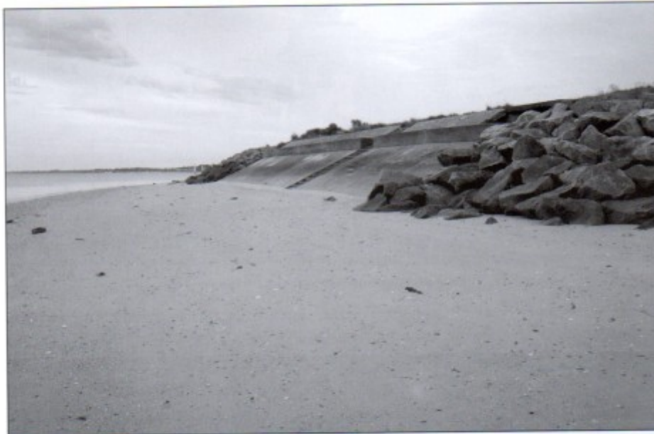
La digue et l'enrochement pour protéger le tombolo, en août 2007. Ph. J.-P. Penisson.
